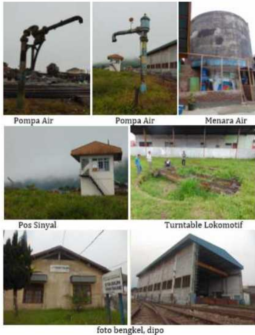
Gambar 4.2. Fasilitas Pendukung Stasiun Kereta Api Kota Padang Panjang
